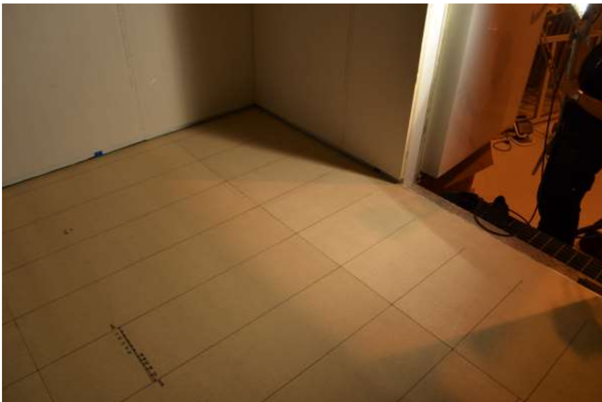
Figur 18 Färdigt golv - 12mm spånskiva.
