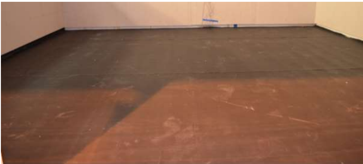
Figur 17 Stegljudmatta placerad direkt ovanpå golvvärmen (gjuten platta eller värmefördelande aluminiumplåtar).
